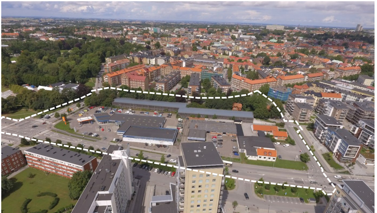
Befintlig markanvändning inom Kv Margretedal samt omkringliggande bebyggelse och stadsbild. Planområdet har markerats med streckad linje.
