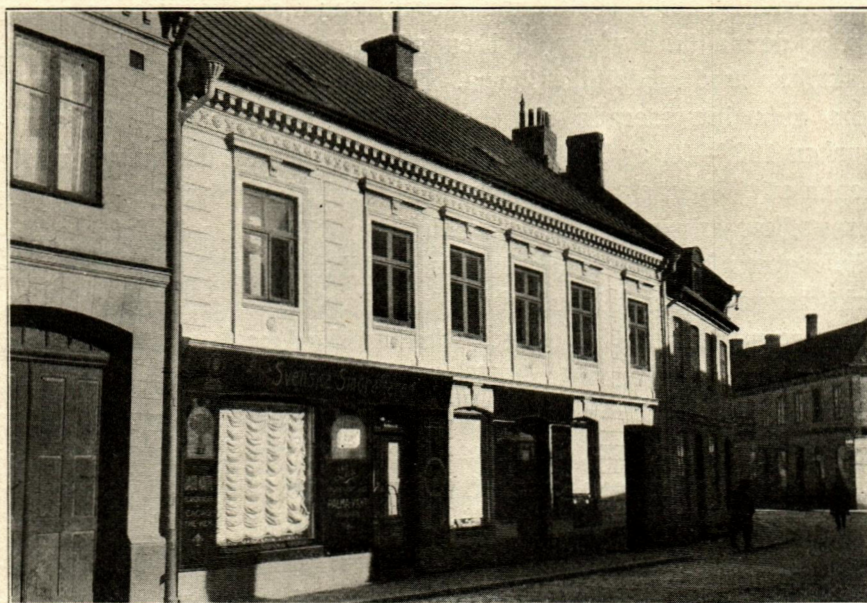
Fig. 22. Huset Skomakaregatan 5, som ursprungligen visade ett enklare yttre, fick under senare delen av 1800-talet sin nuvarande dekorerings.
