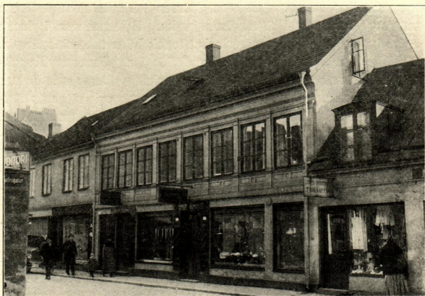
Fig. 18. Elmqvistska huset, V. Mårtensgatan 6, som egentligen består av tvenne äldre hus, fick omkring år 1870 en pilasterindelning i övre våningen.
