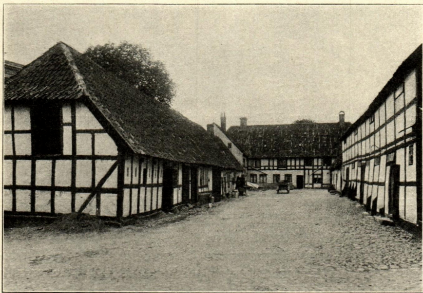
Fig. 5. Wickmanska gården, i hörnet av Bredgatan och Paradisgatan, är ett typiskt exempel på en gammal köpmansgård. Samtliga byggnadslängor äro i korsvirke. Den i fonden, utefter Bredgatan, är uppförd 1788, de andra längorna byggdes tio år senare utom den tvåvåninga till höger å bilden, som förskriver sig från 1800-talets början.
