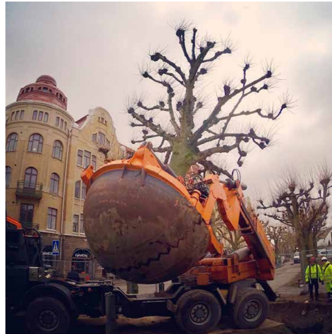
Från trädflytten på Clemenstorget inför spårvägsbyggandet.
