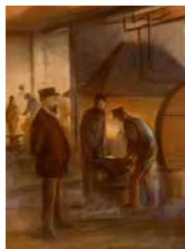
Smedjan i Carl Holmbergs Mekaniska Verkstad. Detalj av målning av Valfrid Nelson 1892.
