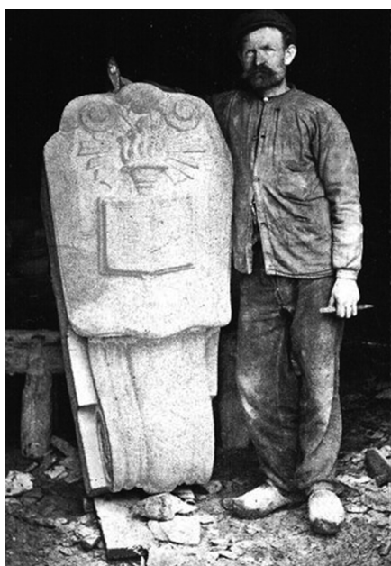
Stenhuggare Mattias Nilsson med sin utsmyckning för Lindebergsska skolans portal.
