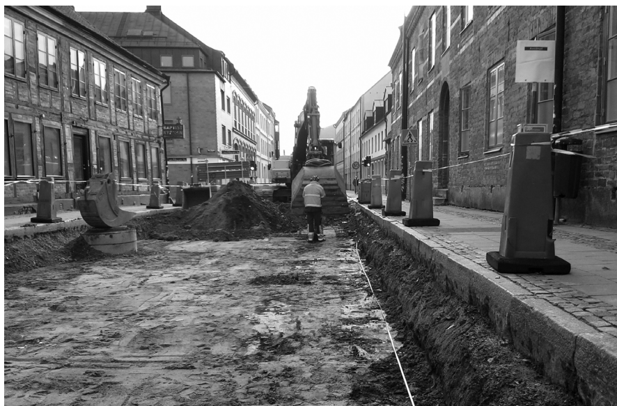
Smågatstenen avlägsnas vid grävarbeten på Stora Södergatan mellan Drottensgatan och Svanegatan i oktober 2013
