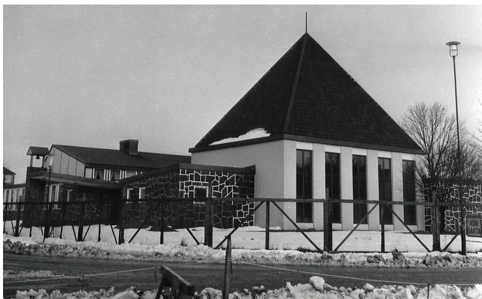
Lunds f.d. Tingsrätt med den enorma pyramidformen – "evighetssymbolen för samhällets viktigaste byggnader". Foto: privat.
